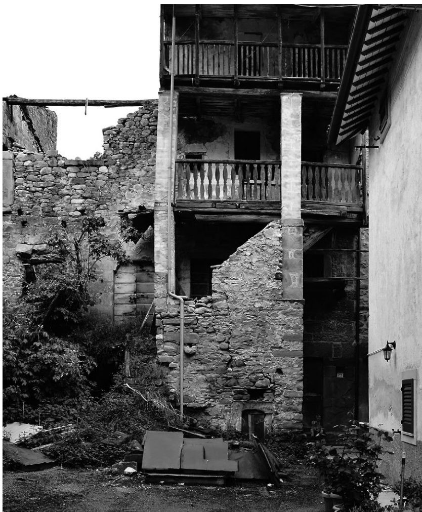
Fig. 1 - Dettagli costruttivi ricorrenti: la verdasca, Trisungo del Tronto (AP), (fonte: Simone Porfiri, 2018).
