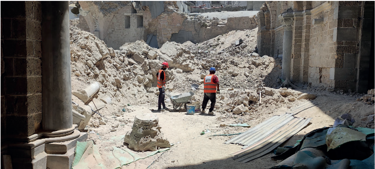
Fig. 5 - Lavori in corso presso la Grande Moschea Al-Omari a opera di RIWAQ, con il supporto di ALIPH, giugno 2025 (Archivio RIWAQ). Ongoing work at the Great Omari Mosque by RIWAQ supported by ALIPH, June 2025 (RIWAQ Archive).
