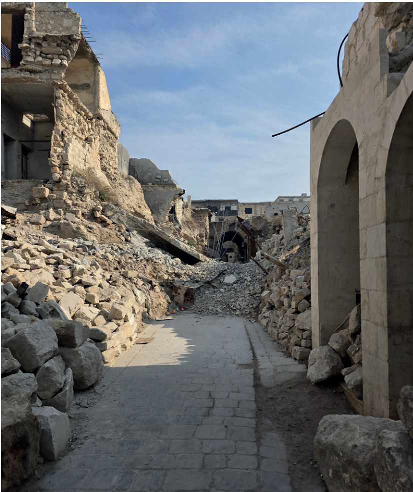
Fig. 6 - Distruzione in un quartiere residenziale storico nella Città Vecchia di Aleppo, Siria. Fotografia di Dalia Mokayed, 2025.
