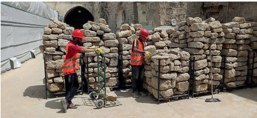
Fig. 6 - Lavori in corso presso la Grande Moschea Al-Omari a opera di RIWAQ, con il supporto di ALIPH, maggio 2025 (Archivio RIWAQ). Ongoing work at the Great Omari Mosque by RIWAQ supported by ALIPH, May 2025 (RIWAQ Archive).
