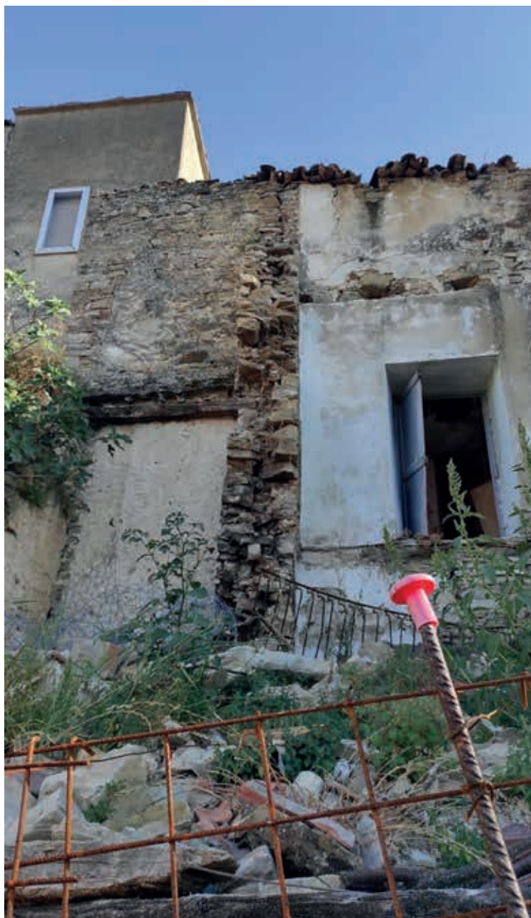
Figura 1.2. Crolli di costruzioni in muratura nel centro storico di Trivigno (Potenza).
