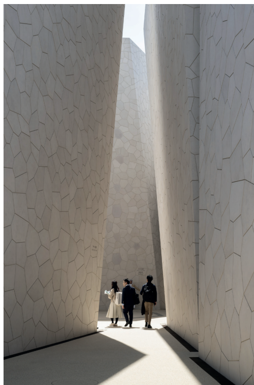
Fig. 6 - Le volumetrie del padiglione del KSA ricordano le forme organiche dei villaggi tradizionali Sauditi: la loro rete di vicoli e le proporzioni degli edifici, così come i modi in cui questi spazi vengono attraversati e apprezzati. Le facciate sono rivestite di un composito di pietra Saudita leggera, progettato per essere assemblato e disassemblato efficientemente. KSA Pavilion, 2025 Osaka Expo, Japan, fotografo Nigel Young.
