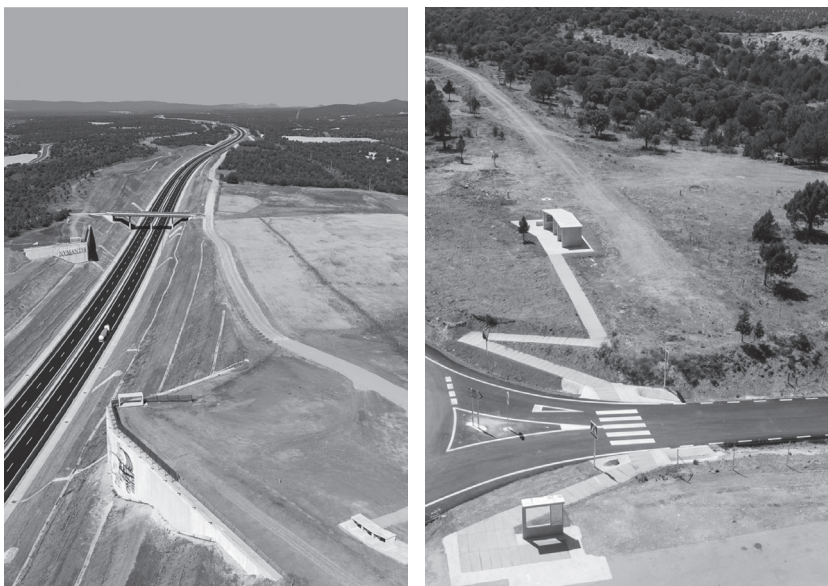
Fig. 3 - Interventi di architettura per la messa in valore della via romana Numancia-Uxama presso le aree d'interpretazione lungo l'autostrada A11. Fotografie da: Álvarez Álvarez D., de la Iglesias Santamaría M., Fernández Raga S., Rodríguez Fernández C. (2022) "Proyecto, Paisaje e Infraestructuras. Intervenciones arquitectónicas en la vía romana Numancia-Uxama", in Moreno Gallo I. (ed.) (2022).
