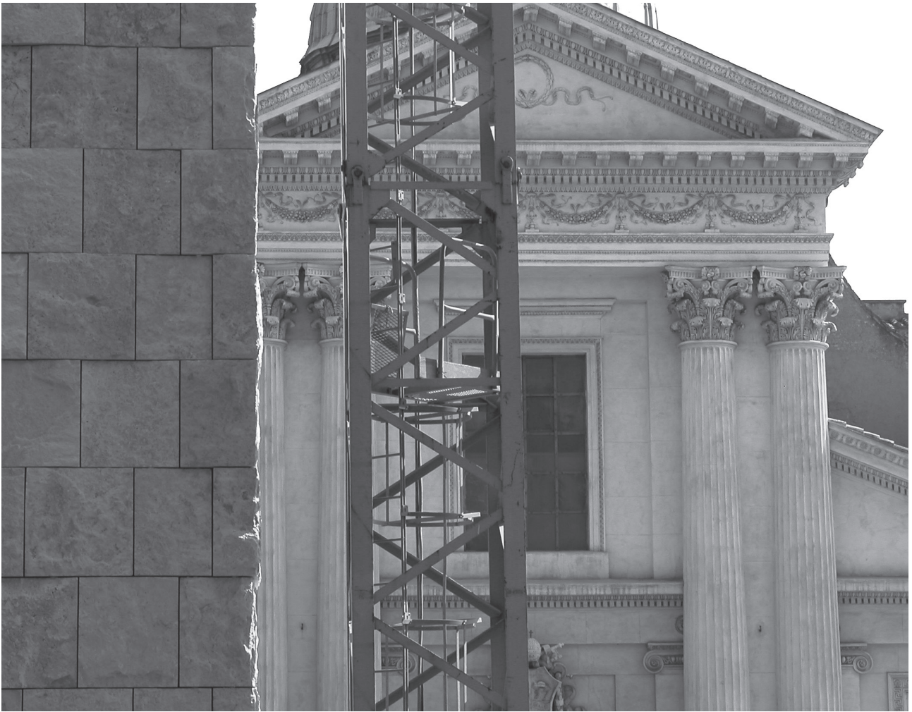
Fig. 4 - Chiesa di San Rocco all'Augusteo (Giuseppe Valadier) con in primo piano il muro del Museo dell'Ara Pacis in costruzione (Richard Meier & Partners).
