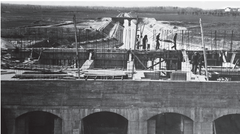
Fig. 6 - L'impianto idrovoro della Finarda a Piacenza in costruzione, 1930 circa. Archivio storico del Consorzio di Bonifica di Piacenza.
