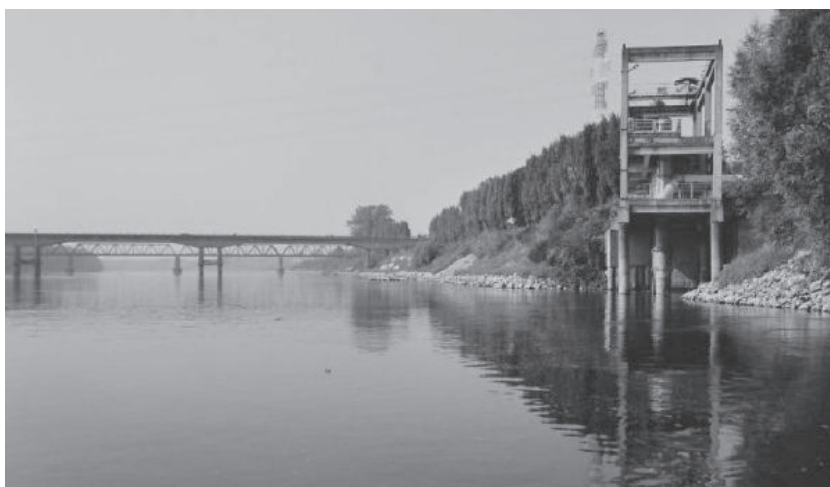
Fig. 3 - (Sopra) Argine maestro sul Po tra Orio Litta e Pizzighettone, ©Albano Marcarini; (sotto) Impianto di sollevamento sul Po a Casalmaggiore, Lombardiabeniculturali, foto Gabriele Basilico. (Above) Main embankment on the Po in the Lodigiano, ©Albano Marcarini; (below) Lifting plant on the Po at Casalmaggiore, Lombardiabeniculturali, photo Gabriele Basilico.
