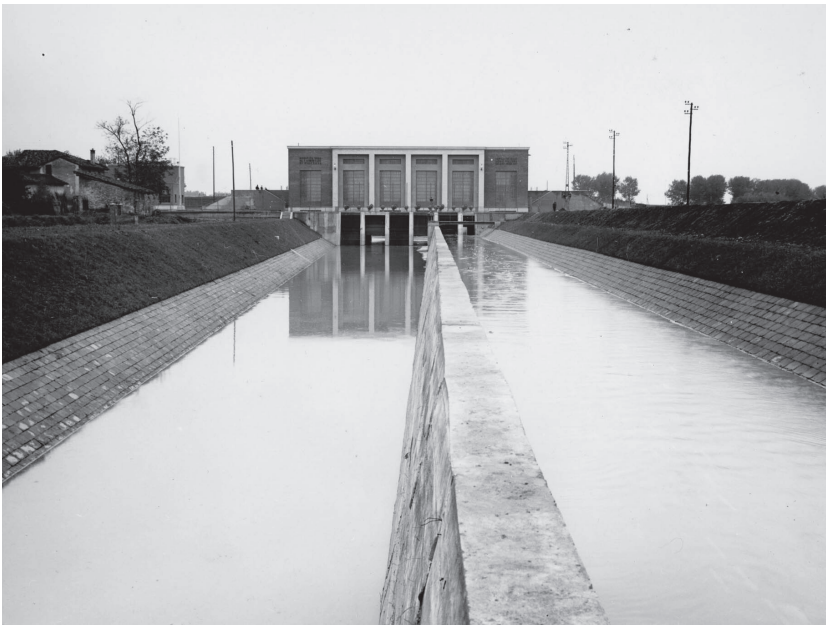
Fig. 5 - L'impianto idrovoro della Finarda a Piacenza, 1929-1932, Archivio storico del Consorzio di Bonifica di Piacenza.
