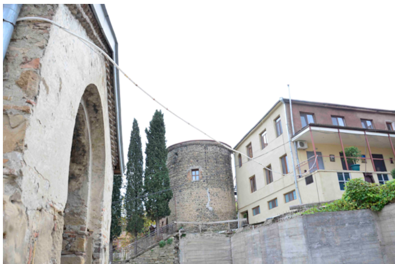
Figura 6. Presenza di cavi sospesi. Foto: Giuseppe Maino.
